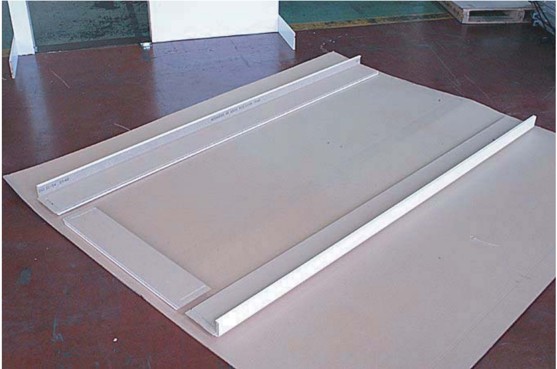
ドア枠(左右)と鴨井で枠を組み立てます
